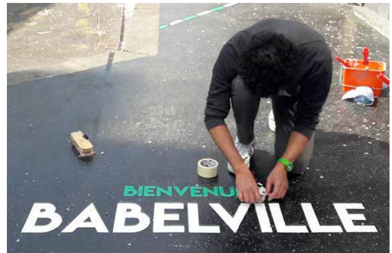
Opérations divan et installation de la signalétique
